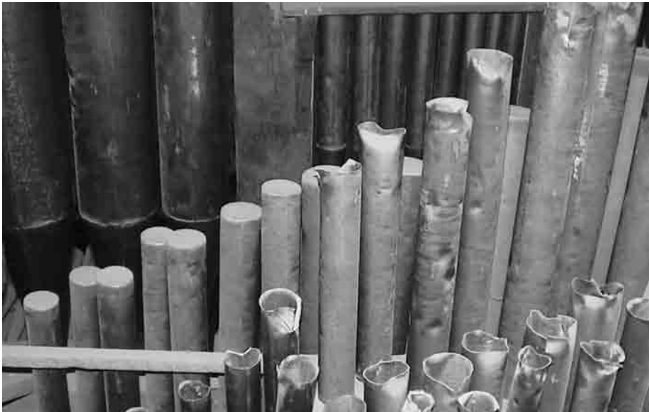
Tubería sobre secreto antes de la restauración.
