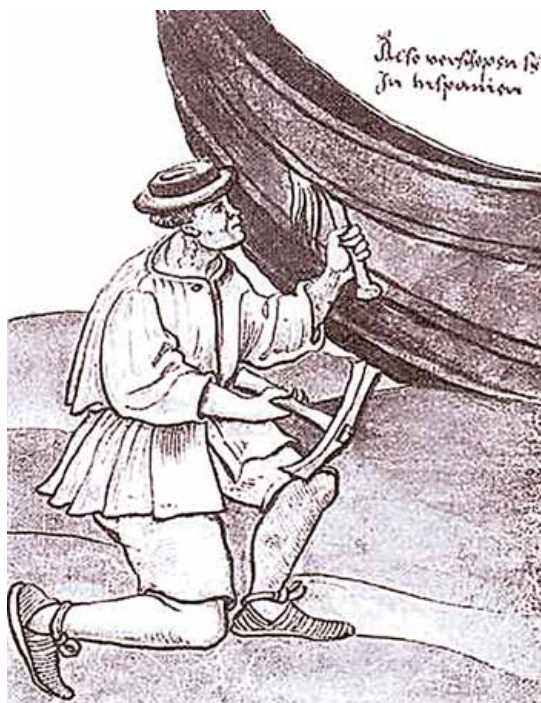
15.9. Calafateador. Levanta el dañado sello de estopa y brea entre las tablas de un navío, en el marco de las operaciones de carenado.
