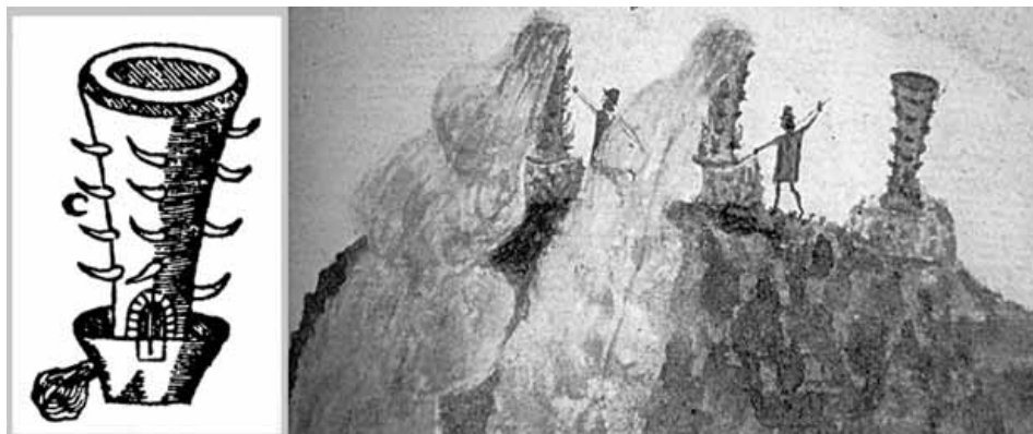
13.11. Guaira (según ilustración de la obra Arte de los Metales , de A. Alonso Barba) e indios fundiendo minerales en guairas, «guairando» (ilustración del siglo xvi, manuscrito K3, The Hispanic Society of New York ).
