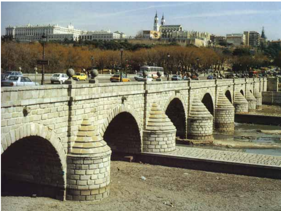
9.4. Puente de Segovia, sobre el Manzanares en Madrid. Juan de Herrera, hacia 1580.
