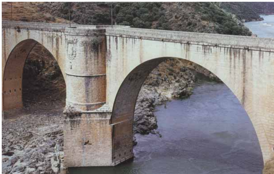
9.5. Puente de Almaraz, sobre el Tajo. Pedro de Uría, 1537.
