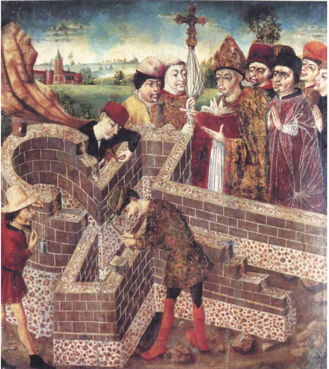
3.8. Construcción de una iglesia dedicada a San Miguel (Círculo del Maestro de Ávila, último cuarto del s. xv, Museo catedralicio abulense). Ilustración de la técnica constructiva tardomedieval: muros de revestimiento de piedra labrada con lecho de cal y canto en su interior, sobre cimientos de argamasa. Se muestran instrumentos: pico para tallar la piedra, plomada y escuadra para realizar el levantamiento, y compás, que distingue al maestro de obras.
