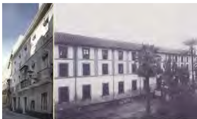
Fachada de la línea interior reformada
