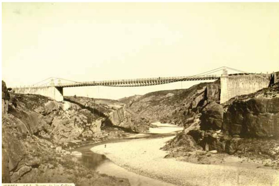
9.22. J. Laurent y Cía. «Huesca - 464 - Puente de las Cellas» [sic], en Obras Públicas de España, h. 1867 (reproducida en Revista de Obras Públicas, 1897 y 1936).
