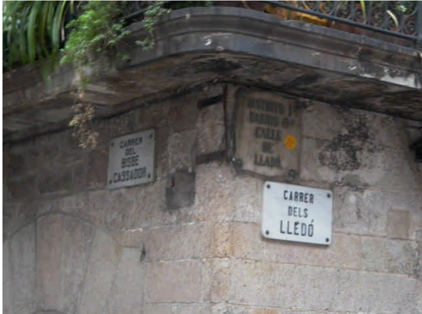
Lámina 9. Plaza de San Justo donde estaba situada la antigua casa Cassador.
