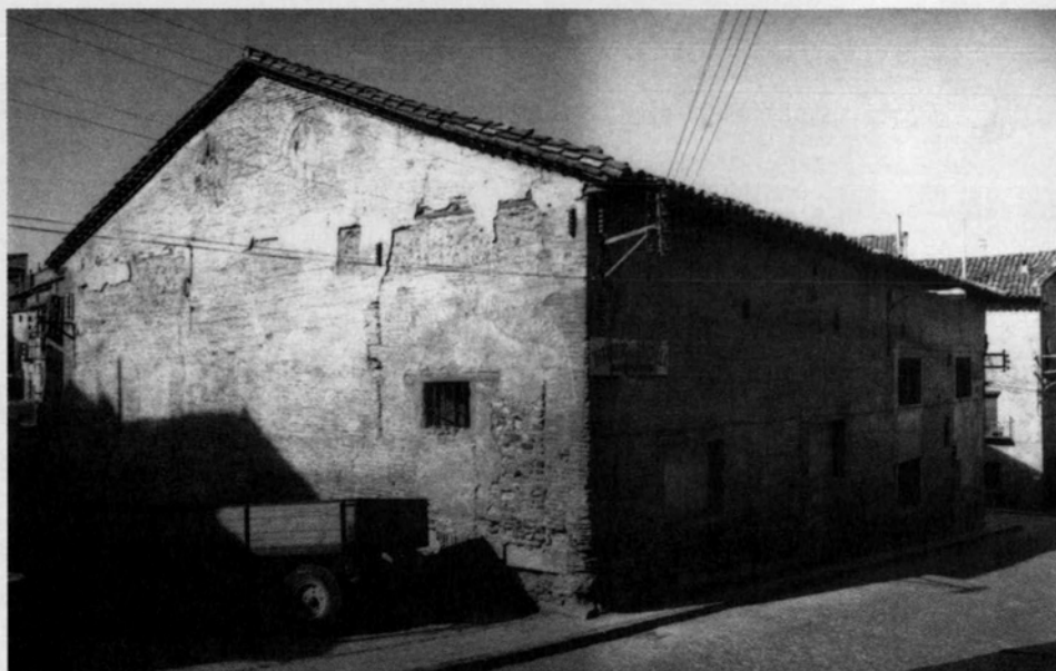
16. Antigo Teatro de La Almeyora –desaparecido–. Fotografía Ayuntamiento de Tarazona.
