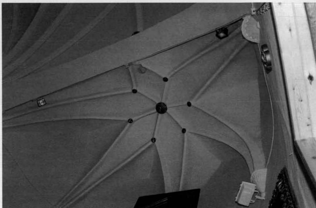
Abovedamiento de la capilla mayor. Foto Archivo C.E.T.
