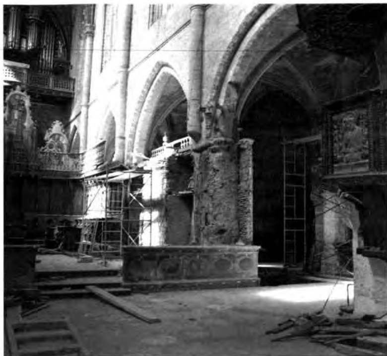
Proceso de dismantelamiento del coro en 1985. Foto Archivo C.E.T.
