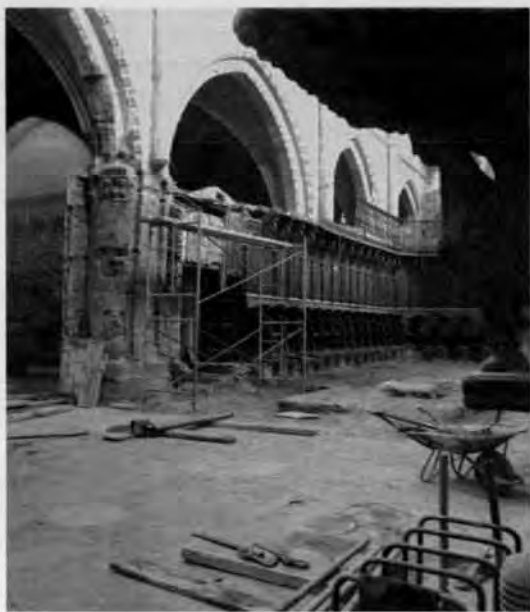
Proceso de desmantelamiento del coro en 1985.
