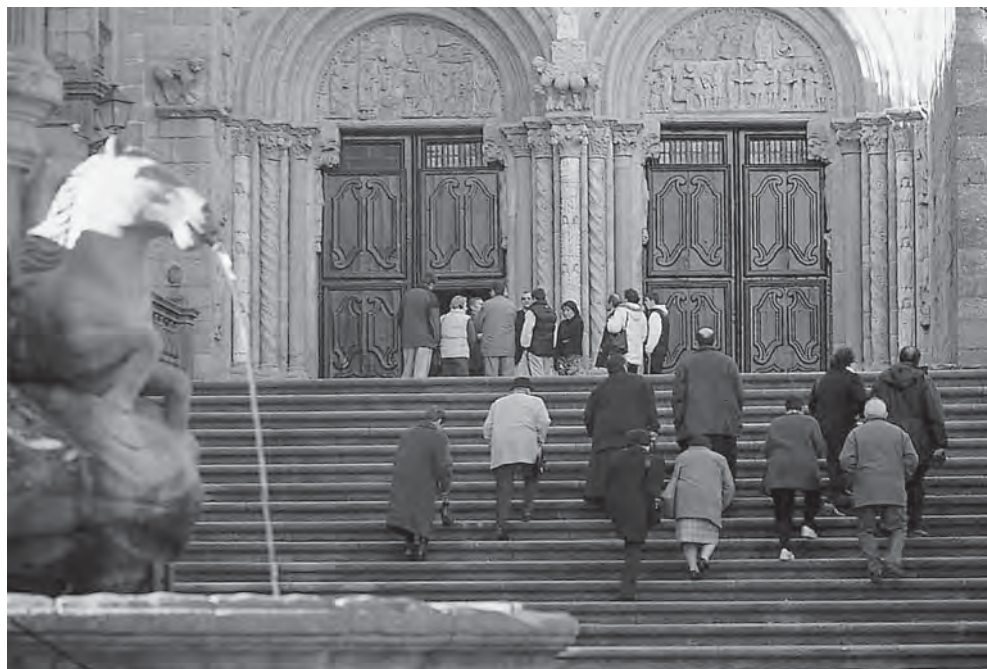
Catedral de Santiago: Fachada de Platerías.
