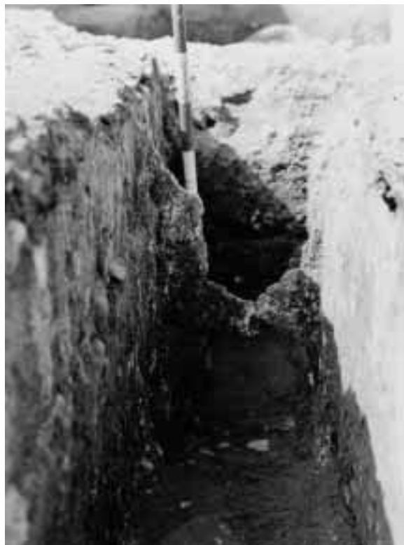
FIG. 22. Canal de desagüe. Tramo I. Tajadera para la regulación del caudal de agua. Fot. Archivo Museo de Zaragoza.
