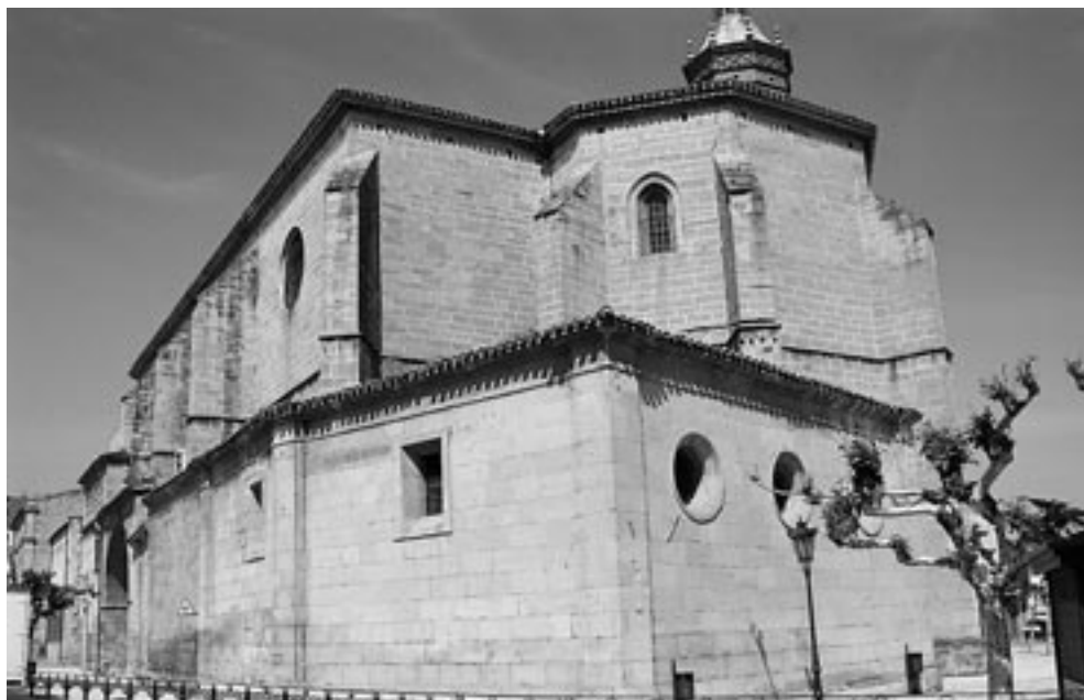
Lámina 3. Iglesia de Santa María en Fuenmayor. Exterior sudeste.
