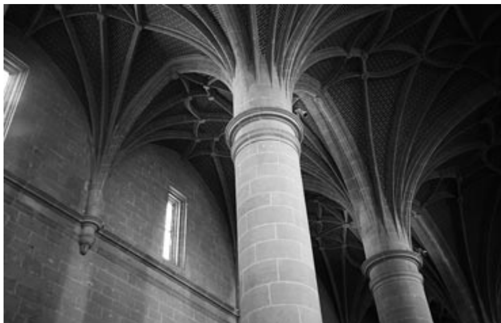
Lámina 14. Iglesia de San Juan Bautista en Cintruénigo (Navarra). Detalle de pilares.
