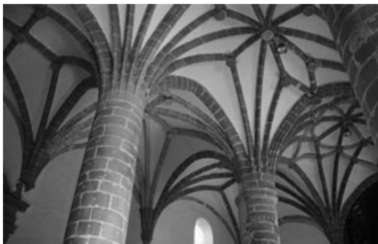
Lámina 12. Iglesia de El Salvador en Pedroso. Detalle de pilares y bóvedas.
