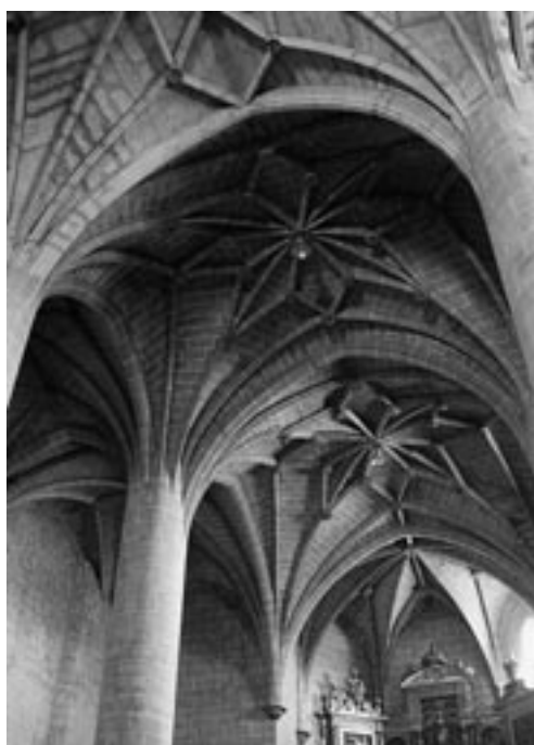
Lámina 16. Iglesia de Santa María en Fuenmayor. Bóvedas de la nave central.
