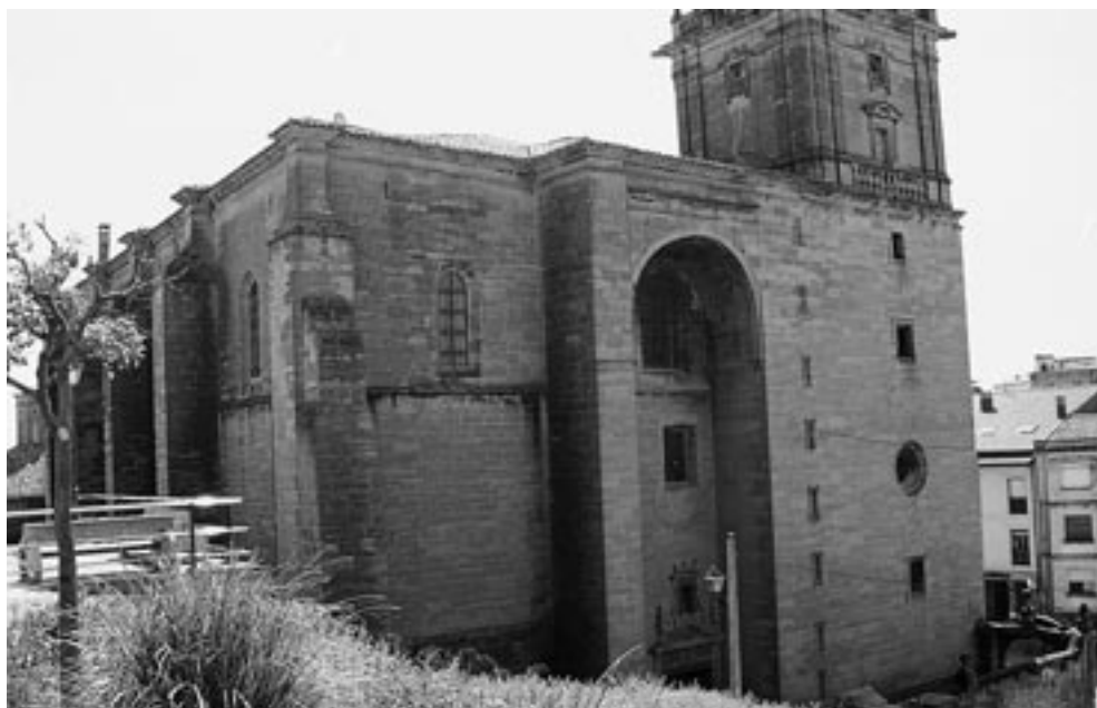
Lámina 18. Iglesia de Santo Tomás en Haro. Fachada occidental.
