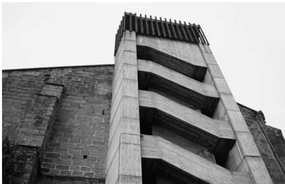
Lámina 20. Iglesia de San Martín en Camprovín. Exterior occidental.
