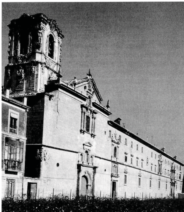
Figura 5. Fachada meridional del Convento de Predicadores y Universidad Pontificia, en Orihuela.
