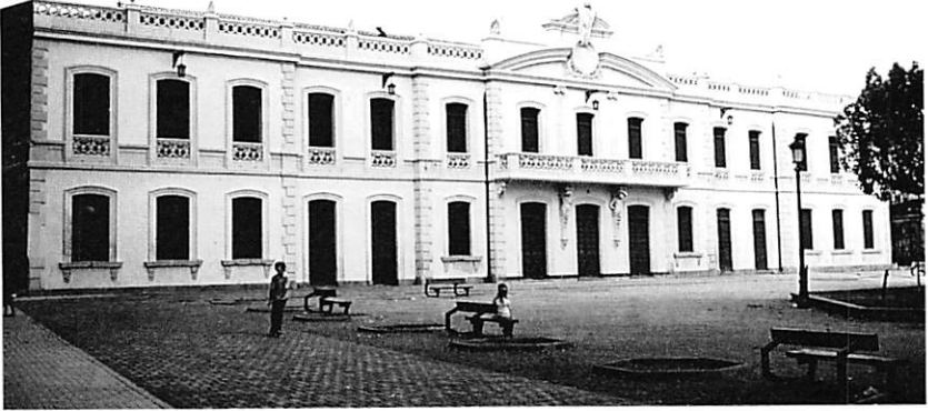
Fachada exterior de la estación de Utrillas en Zaragoza. Imagen tomada después de cerrado el ferrocarril y haberse pintado y adecentado la fachada. Foto autor, 1982.
