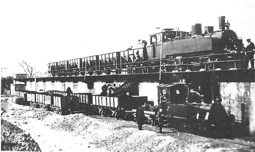
Locomotora n.º 31 y vagones tolva en el muelle de descarga de Carboneras. Abajo, la máquina de maniobras n.º 21 espera sean cargados los vagones de M.Z.A. para remolcarlos a la estación de Miraflores. Archivo Municipal de Zaragoza, 1920.
