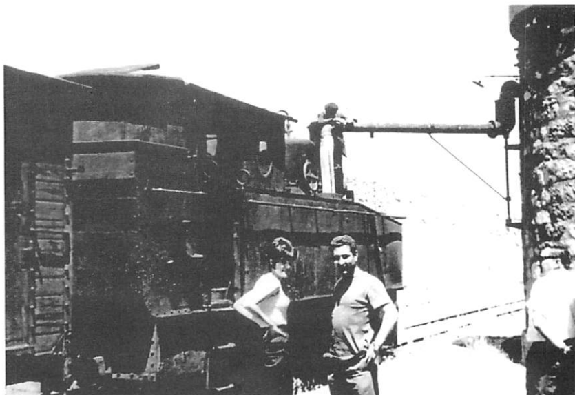
Locomotora n.º 7 "CARBONERA" y visitantes en la toma de agua de la estación de Ventas de Muniesa. Año 1966.
