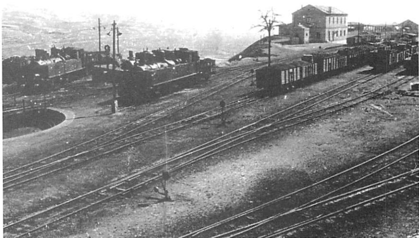
Estación de cabecera denominada Utrillas-Montalbán con locomotoras, vagones, vías y plaza de maniobras donde se recepcionaban los trenes y se formaban otros en sentido descendente. El emplazamiento pertenece al municipio de Martín del Río, lugar idóneo para este fin. Foto F. Llauradó, 1965.
