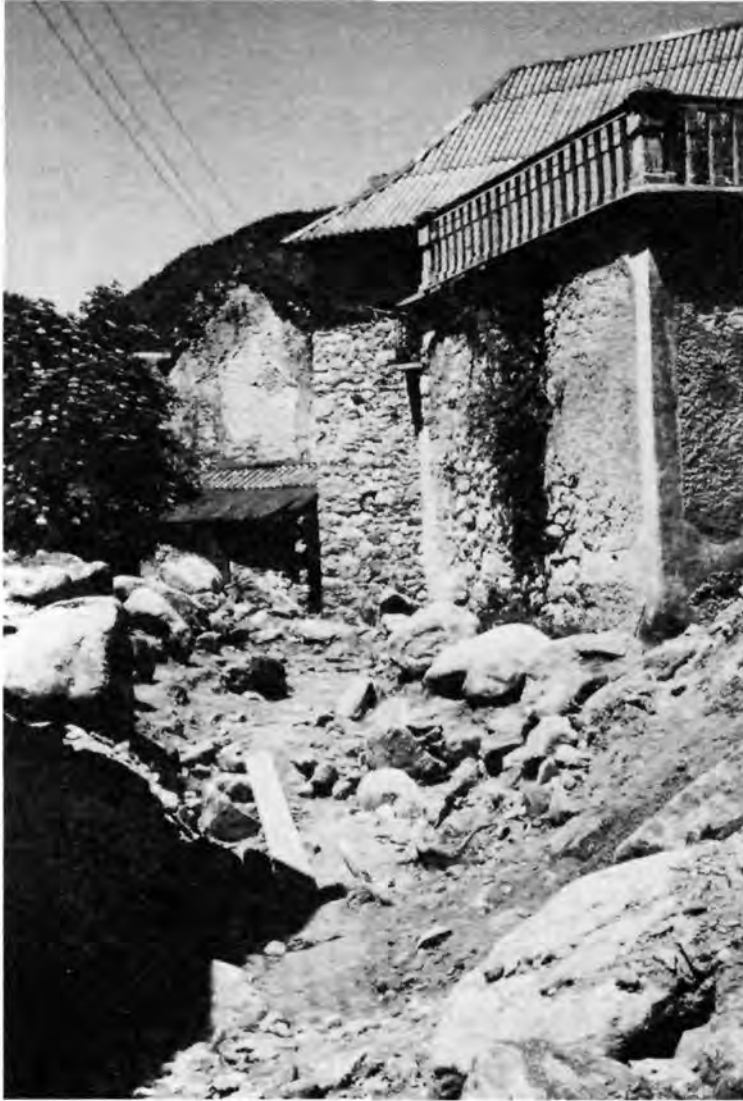
Preparando las calles de Parzán para el suministro de agua (15 de julio de 1984).
